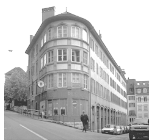
5 Cette tête de bâtiment arrondie est agrémentée de nombreux et importants percements.
