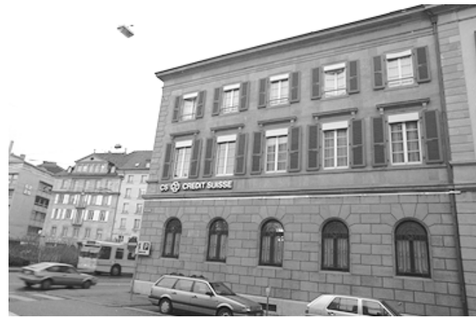
3 Les encadrements, les bandeaux et le socle sont caractéristiques de cet ensemble.
