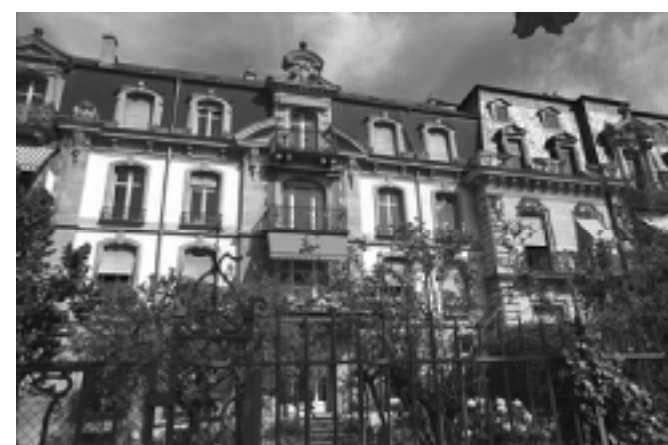
5 Les façades sont toutes symétriques, excepté celles des bâtiments de tête.
