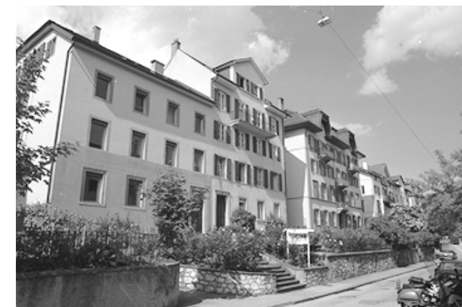
4 L'ordre semi-contigu, les pignons au sud donnant sur la rue et les jardins forment ici un ensemble remarquable.
