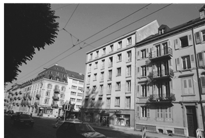
5 La division de la façade en étages de même hauteur et les trois rangées de percements en toiture sont des éléments particulièrement dérangeants.
