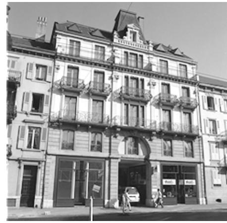
1 Ce bâtiment de référence présente un socle rehaussé percé d'un passage, une corniche alignée sur celles des autres immeubles, des balcons et une tourelle en toiture.
