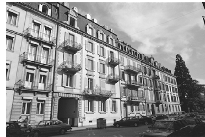
4 Les rythmes créés par les façades, les balcons, les lucarnes à encadrement, la corniche alignée et les toits à la Mansart sont caractéristiques de cet ensemble.
