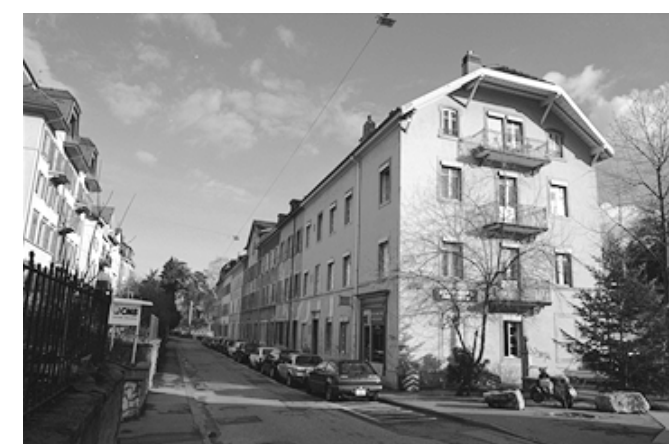
6 Un bâtiment de référence qui illustre le mode de construire des "maisons d'ouvriers".
