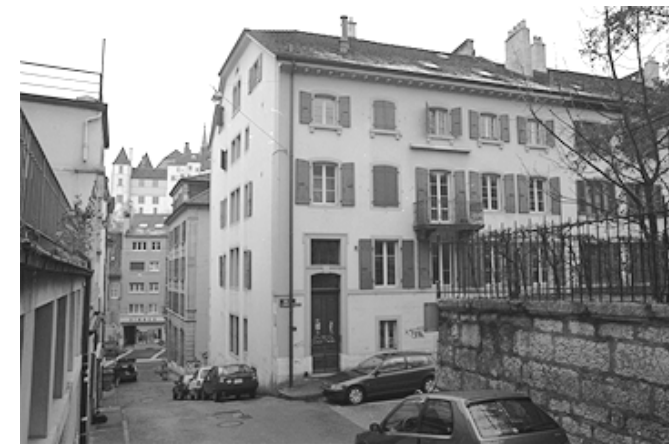
4 Ce bâtiment présente un toit simple sans lucarne et un bandeau soulignant le rez-de-chaussée.
