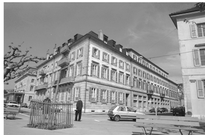
5 Les pignons sud sont caractérisés par la présence de balcons.
