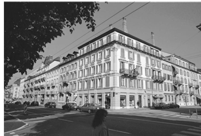
3 Le rehaussement de ce bâtiment d'angle par un étage en attique perturbe la ligne des toitures de ce groupe d'immeubles.
