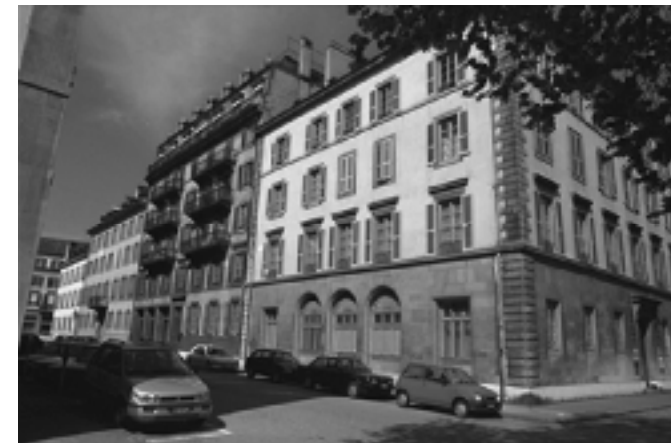
3 Le bâtiment d'angle est une référence pour l'ensemble. Le rehaussement rompt la continuité de la corniche .
