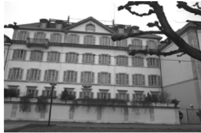
1 Le rehaussement, réussi en soi, est perturbant pour l'ensemble, de même que la suppression du jardin au sud.
