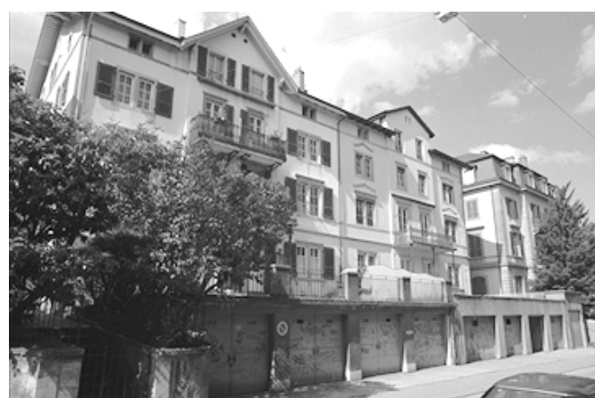
5 Les jardins ont été supprimés pour laisser la place à des annexes abritant des garages mal intégrés à l'ensemble.
