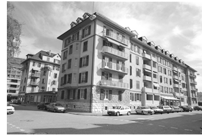
2 Ce groupe d'immeubles présente un socle massif, des balcons, des lucarnes et des bandeaux qui marquent le 1 er et le 3 ème étage.
