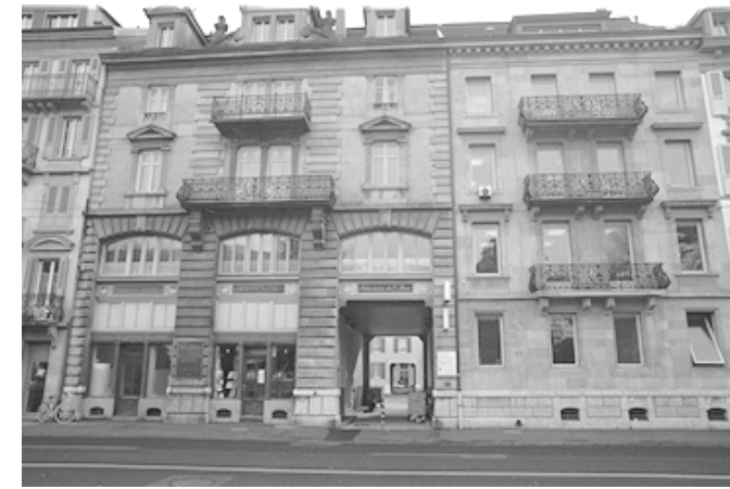
2 Ce bâtiment de référence présente un socle rehaussé percé d'un passage excentré, une corniche , des lucarnes à encadrement et des balcons qui assurent la symétrie.
