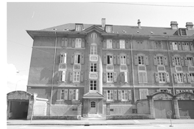
6 Les garages, la cour, l'entrée et la cage d'escalier réapparaissent dans chaque immeuble de ce groupe.
