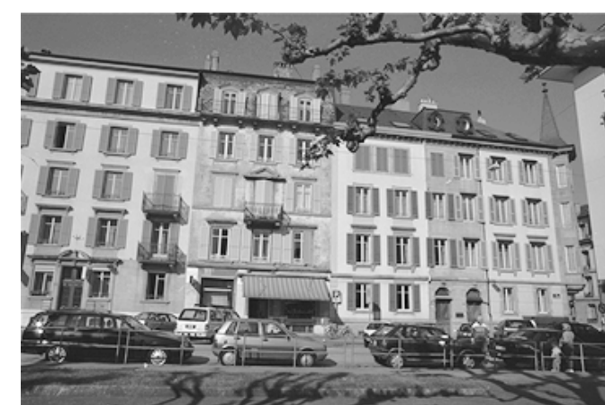
6 Le traitement atypique des toitures perturbe l'organisation caractéristique des façades (socle, bandeaux , corniche , balcon et lucarne à encadrement dans un toit).
