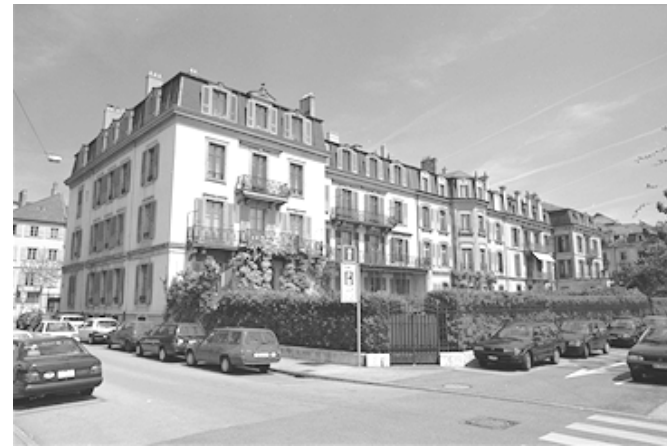
1 La symétrie en façade est typique des quatre groupes de bâtiments formant cet ensemble, tout autant que les toitures mansardées avec lucarnes à encadrements. L'ensemble quai Philippe-Godet frappe par son homogénéité.
