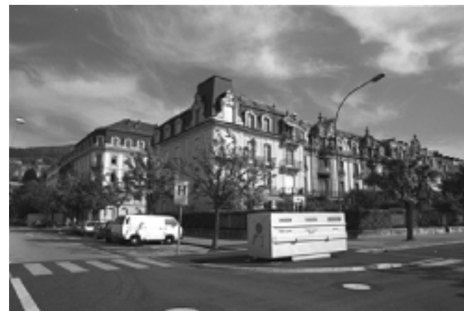
3 La tête ouest est caractérisée par le rehaussement de la toiture.
