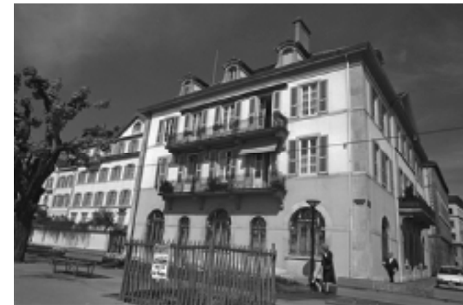
4 Le bâtiment d'angle à l'est du groupe sud est l'élément de référence pour l'ensemble. Il ferme la place Numa-Droz à l'ouest. Il présente une riche modénature .
