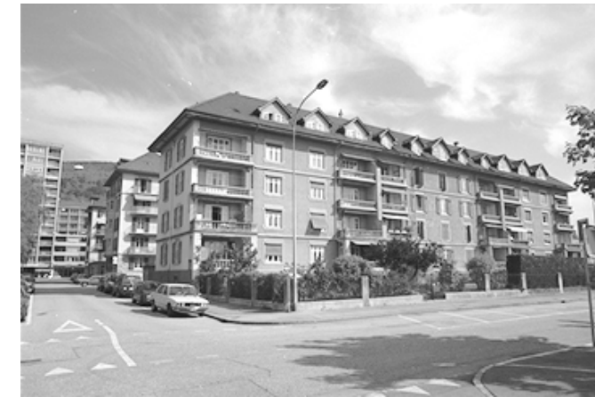
4 Les jardins, les loggias , les larges avant-toits et les lucarnes caractérisent cet ensemble.
