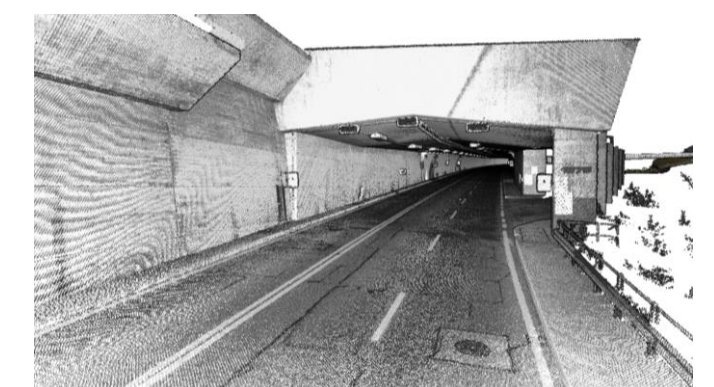
Analyse des ouvrages d'art, relevé des trottoirs et chambres
